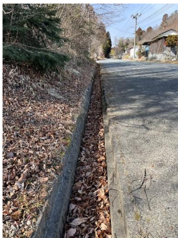
清掃前のU字溝
