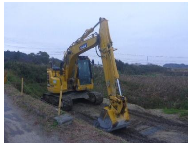
バックホーを使用し、外部流出防止
