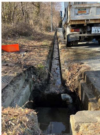
清掃後のU字溝
