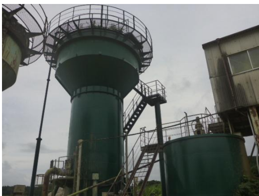
シックナー（沈降分離装置）
